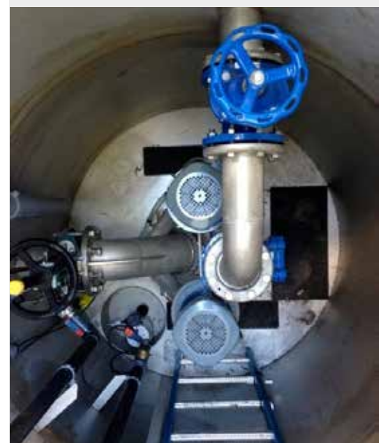
Poste transformé en local technique
